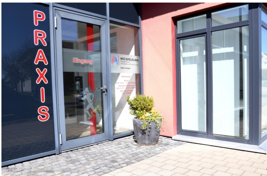
MVZ Eifelklinik Eingangsbereich
